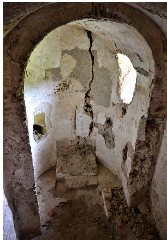
Apsyda kaplicy zamkowej (najstarsza faza budowy zamku)
