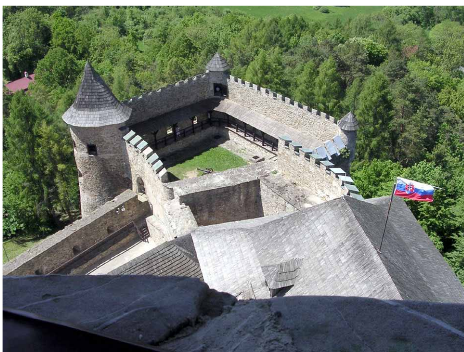
Bastion zachodni, przed nim dachy barokowego pałacu Lubomirskich
