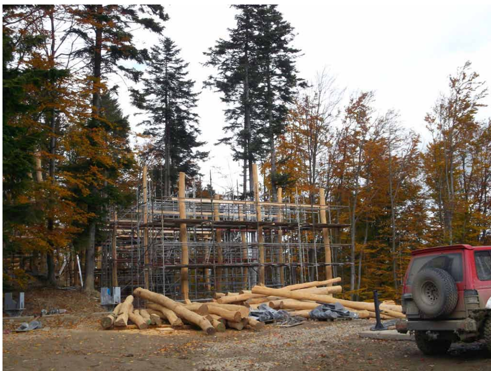
Budowa wieży w Słotwinach
