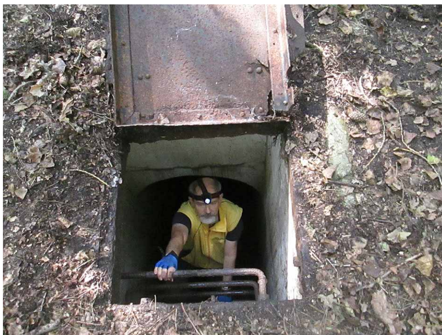
Wyjście awaryjne z tunelu
